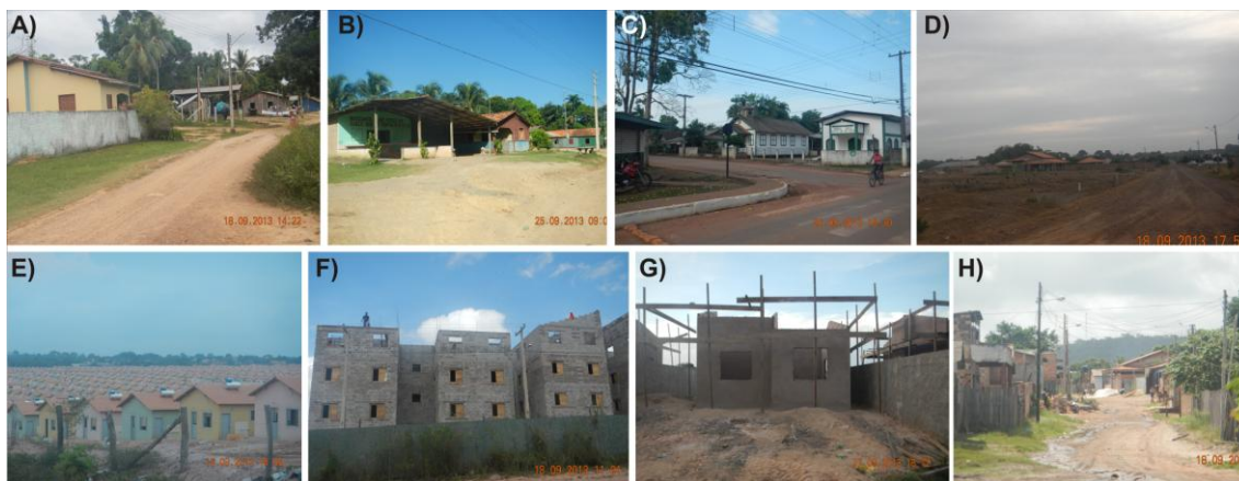
Figura 5.18 - Aspecto geral das comunidades Igarapé da Lama (A) e São Francisco do Mojuí (B); casas do projeto americano em Belterra (C); loteamento recente de alto padrão na BR-163 (D), casas recentes “Minha casa Minha Vida” (E), conjunto residencial vertical (F) e horizontal (G) e ocupação de baixo padrão construtivo (H), em Santarém.
