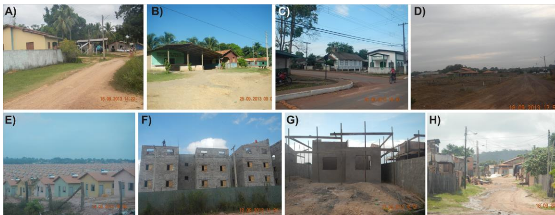
Figura 5.18 - Aspecto geral das comunidades Igarapé da Lama (A) e São Francisco do Mojuí (B); casas do projeto americano em Belterra (C); loteamento recente de alto padrão na BR-163 (D), casas recentes “Minha casa Minha Vida” (E), conjunto residencial vertical (F) e horizontal (G) e ocupação de baixo padrão construtivo (H), em Santarém.
