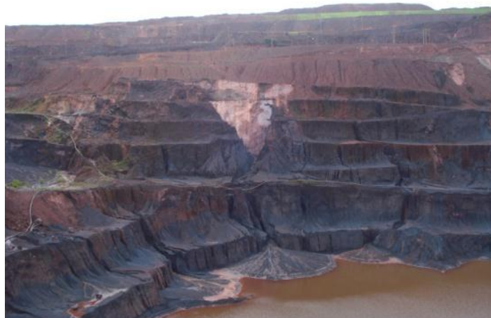
Figura 3.8 - Plano de ruptura envolvendo ao menos quatro (4) taludes da aba leste, Cava 1, Mina N4W. Notar o desmantelamento dos taludes por efeito erosivo, o que indica que se trata de materiais de baixa coesão. Foto tomada a 15 de março de 2012.
