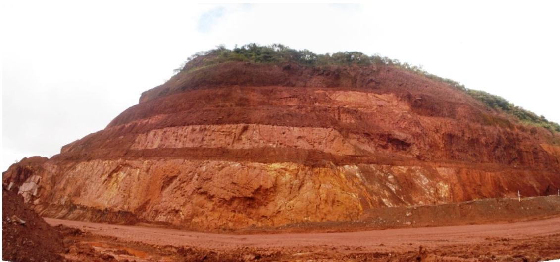
Figura 4.13 – Talude constituído por rocha máfica alterada/muito alterada, onde foram instalados seis prismas refletivos para validação de campo. Consultar a Figura 3.4 para localização em planta dos mesmos.
