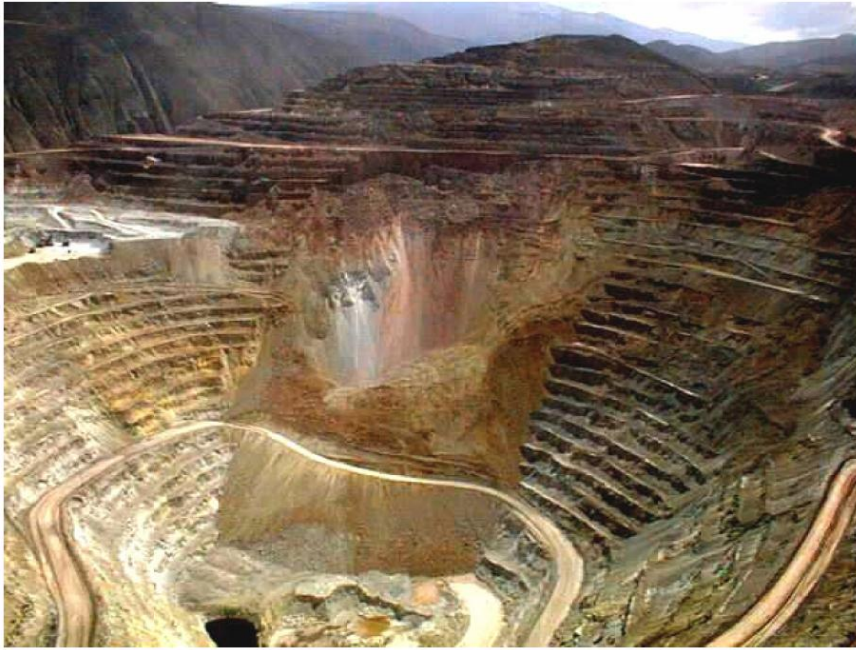
Figura 2.39 - Exemplo de ruptura global em talude de mineração (h = 350 m). Fonte: Hoek et al. (2000).
