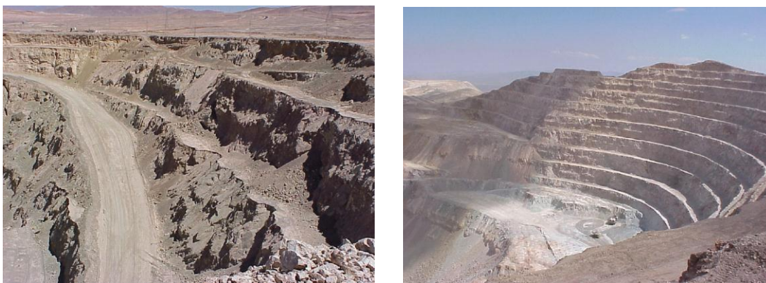
Figura 2.47 - Efeito do uso não controlado de explosivos (à esquerda) e da incorporação do pré-fissuramento como rotina de lavra para a mesma mina.
