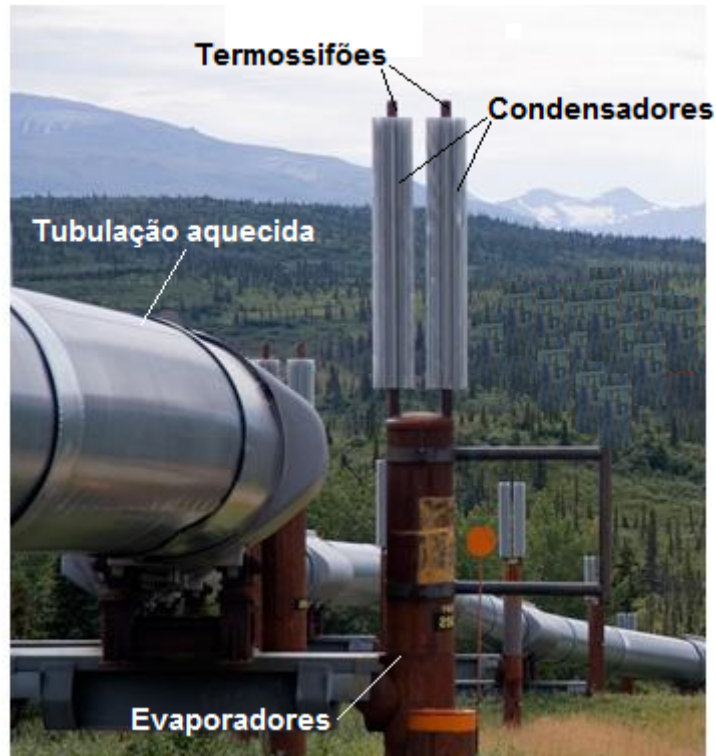
Figura 1.9 - Termossifões empregados em oleoduto.
