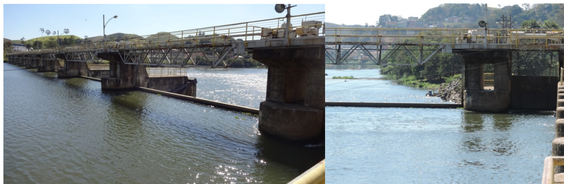
Figura 5 – Barragem da Usina Elevatória Santa Cecília e a única comporta aberta na ocasião da visita.
