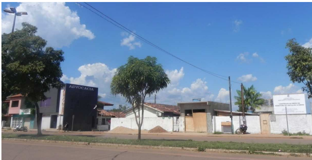
Vista de trecho da avenida Brigadeiro Eduardo Gomes. A placa à esquerda da foto indica a área onde está sendo construída a sede da Promotoria de Justiça de Altamira (foto de agosto de 2013).
