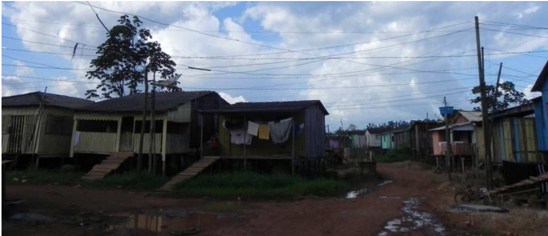
Casas construídas em área periodicamente alagada ao longo do igarapé Ambé. Nota-se que o piso das casas é elevado em relação à via de acesso, que é transitável na época de seca (foto de agosto de 2013).
