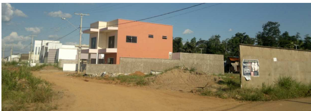
Entrada do condomínio fechado em construção nas proximidades do Xingu Praia Clube (foto de agosto de 2013).
