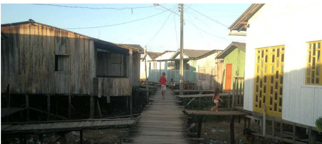
Ocupação em área periodicamente alagada pelo igarapé Altamira (foto de agosto de 2013).
