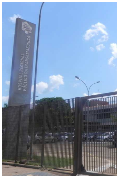
Entrada do Hospital Regional (foto de agosto de 2013).
