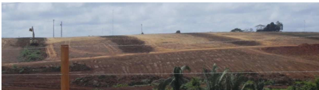
Local das obras do RUC São Joaquim (agosto de 2013).
