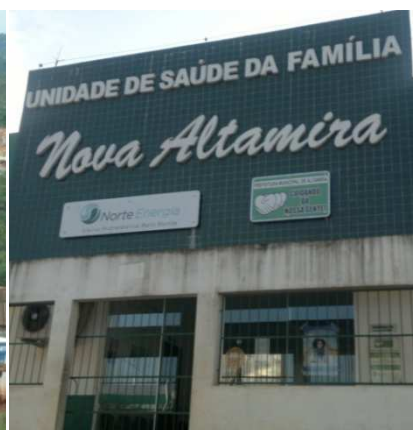
Posto de saúde construído pela NorteEnergia no bairro contíguo ao conjunto habitacional Santa Benedita (foto de agosto de 2013).
