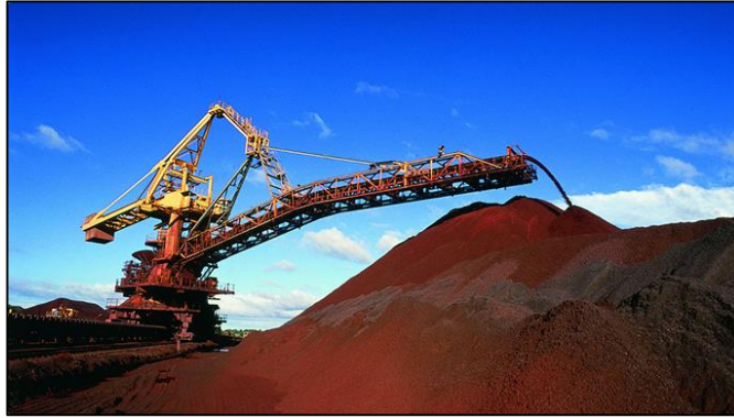
Figura 2.6 - Sistema de empilhadeira em correia transportadora. Fonte: Vale (2015).
