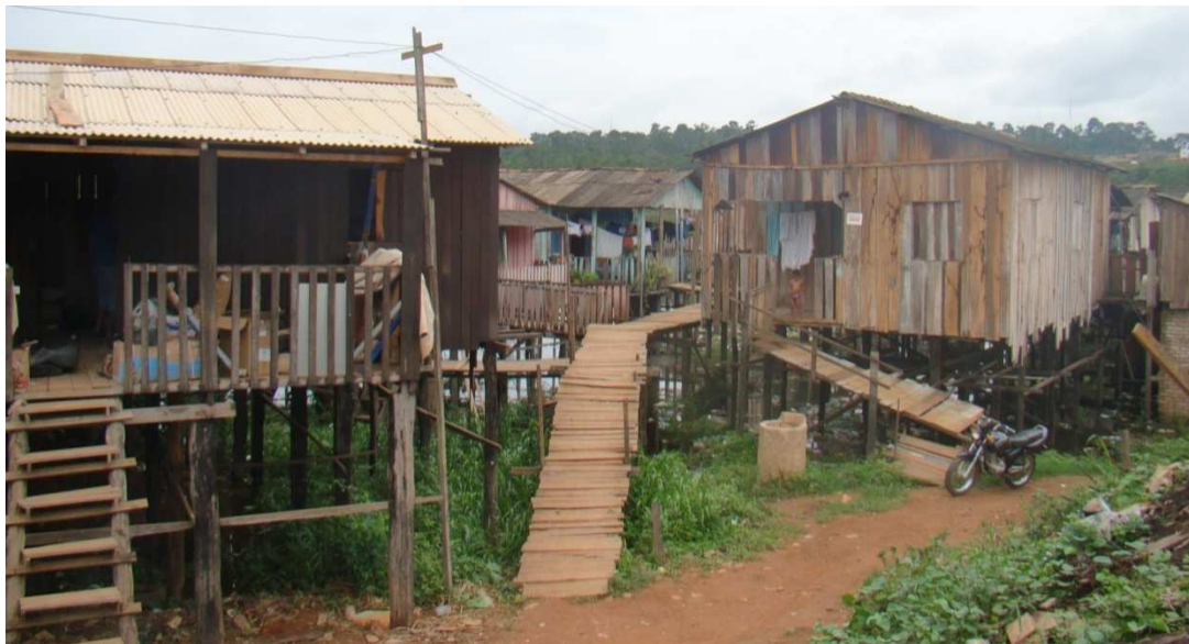
Casas construídas sobre o igarapé Ambé. O acesso é feito pelas “estivas” (foto de janeiro de 2012).
