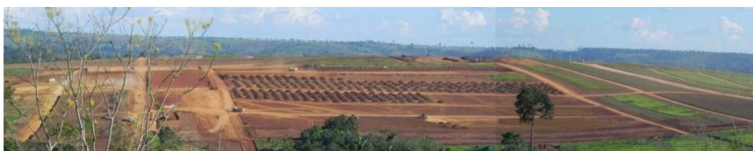
Vista do loteamento Residencial Cidade Jardim (foto de agosto de 2013).
