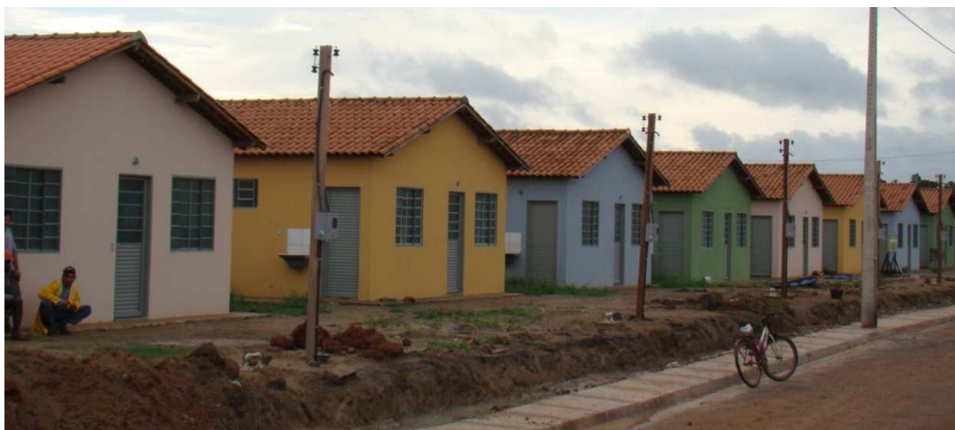
Vista das residências do conjunto habitacional Santa Benedita, em janeiro de 2012, antes de serem ocupadas pelos beneficiários do programa.
