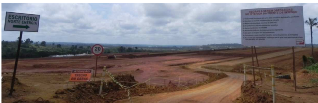
Local das obras do RUC Jatobá (agosto de 2013).
