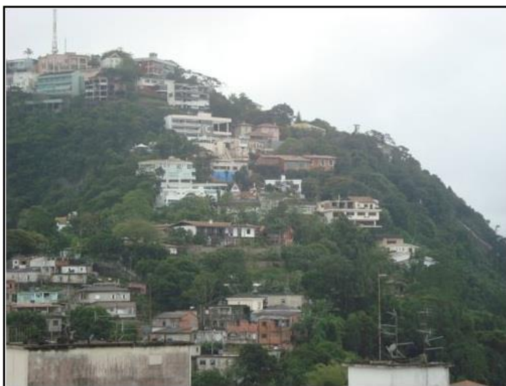
Figura 4.3 - Exemplo de ocupação em encostas suscetíveis, em Santos, SP.
