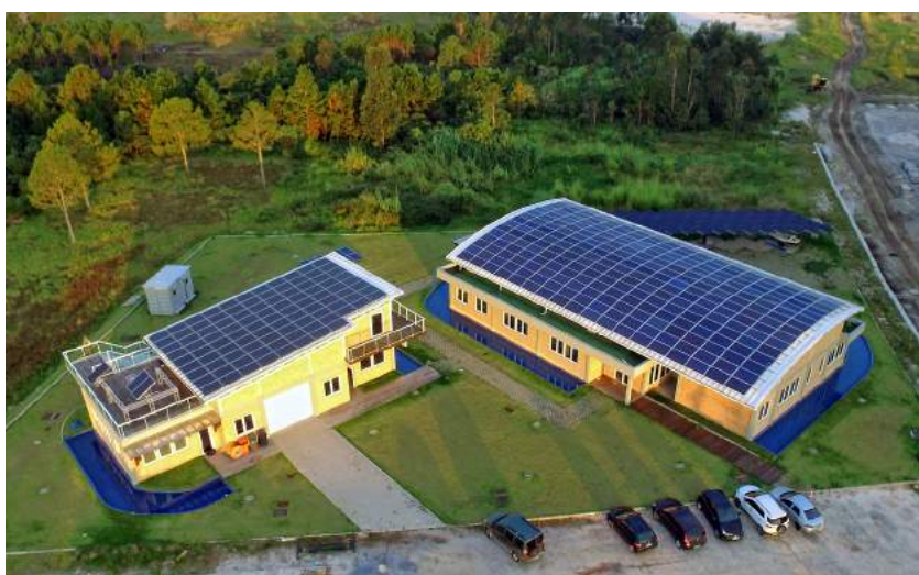
Figura 55. Centro de Pesquisa e Capacitação em Energia Solar Fotovoltaica da Universidade Federal de Santa Catarina em Florianópolis-SC, com 100 kWp de geradores solares fotovoltaicos integrados nas coberturas dos prédios e também do estacionamento.
