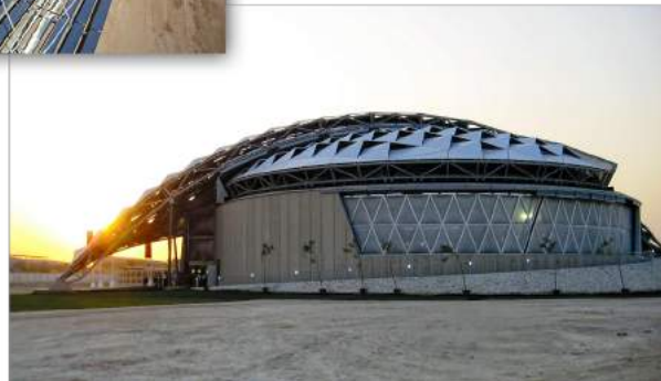
Figura 51. Campo de coletores concentradores de uma instalação de refrigeração solar em uma arena esportiva em Doha, Qatar (Zahler et al., 2011).
