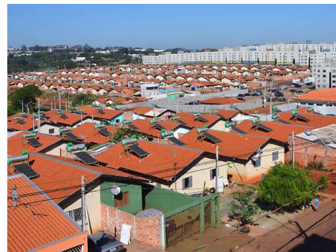
Figura 43. Vista das unidades habitacionais unifamiliares do Residencial Vista Bela (Londrina – PR) com sistemas de aquecimento solar compactos instalados (cortesia: Thalita Giglio).
