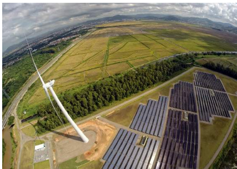
Figura 58. Usina Solar Fotovoltaica Cidade Azul em Tubarão-SC, com potência instalada de 3 MWp e utilizando três tecnologias fotovoltaicas distintas.
