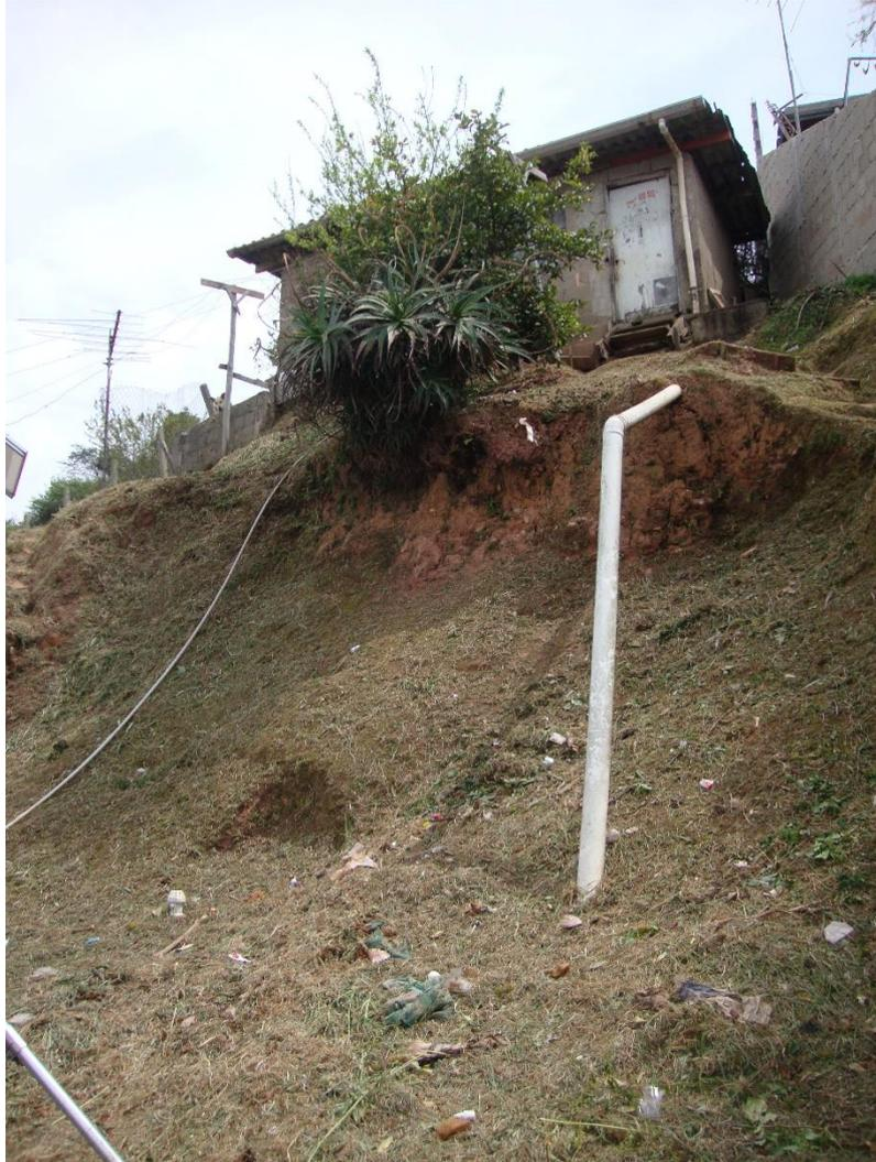
Figura exemplificando instalação precária de tubulação, que pode favorecer a ocorrência de vazamentos.
